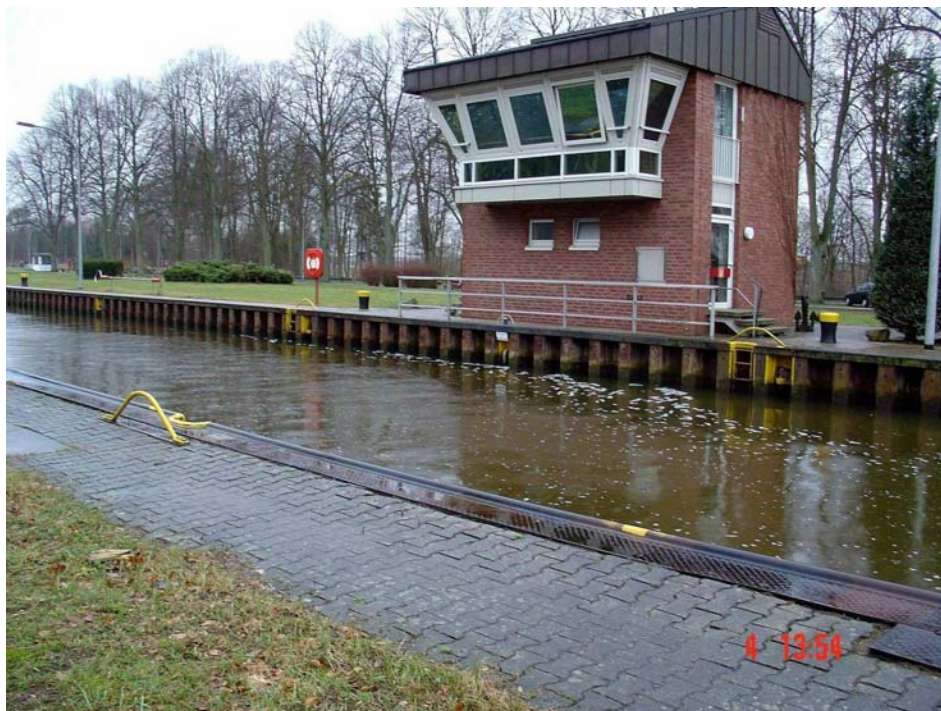
Abb. 7: Schleusensteuerstand der Schleuse Varloh
