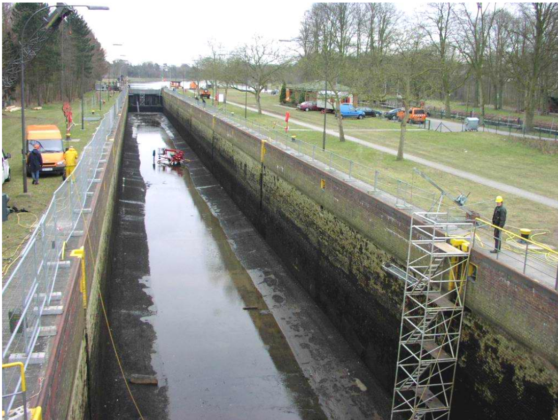
Abb. 8: Schleuse Hüntel mit massiver Schleusenammerwand, hier trockengelegt.
