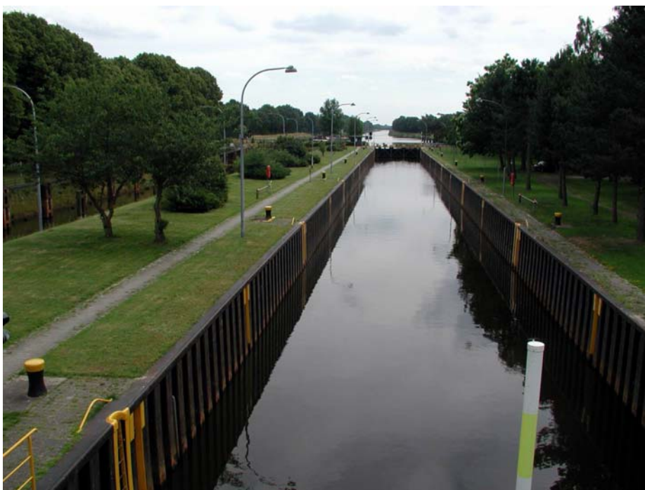
Abb. 3: Die Schleusenanlage Dütthe. Links vom Mitteldamm die alte Schleuse mit geböschter Kammer
